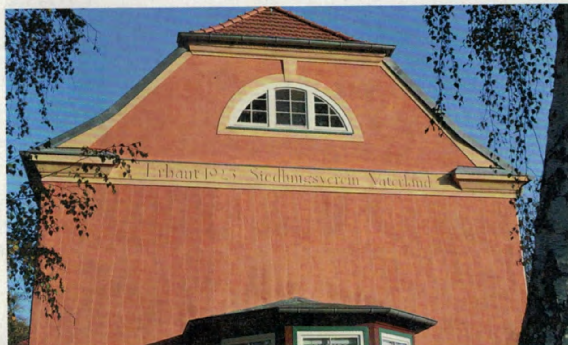
Durch den Einsatz farbiger Sande erhält die Fassade eine natürliche Farbigekeit (Projekt in Potsdam)
